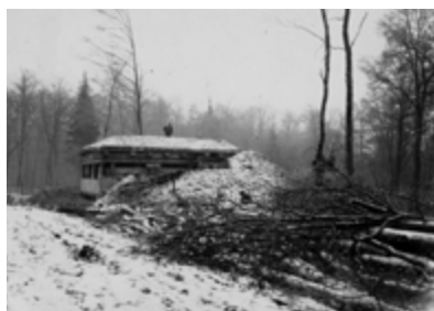
Printemps 1915: fin de la construction du poste d'observation Nord du Largin (commune de Bonfol).
